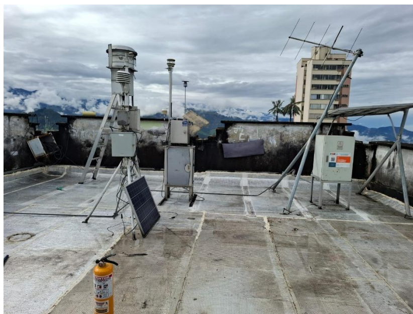
Figura 1. Adecuaciones en la estación Liceo. Marzo de 2025
