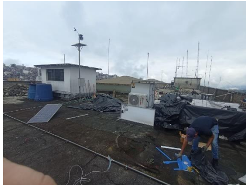
(A) Durante el arreglo la operación fue detenida el 22 de noviembre de 2024
