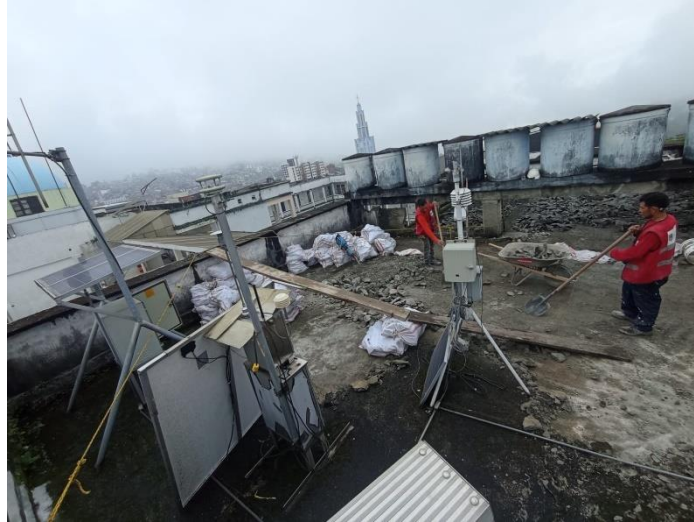
Registro fotográfico 2. Adecuaciones de la estación Liceo. Diciembre 2024
