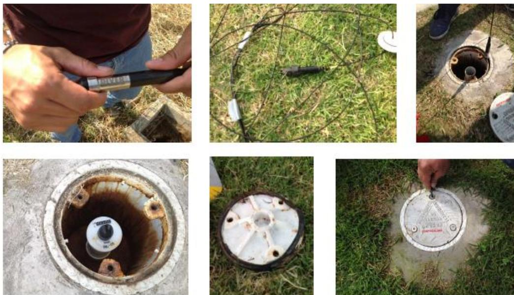
Figura 3: Instalación de los sensores (freatímetros).
